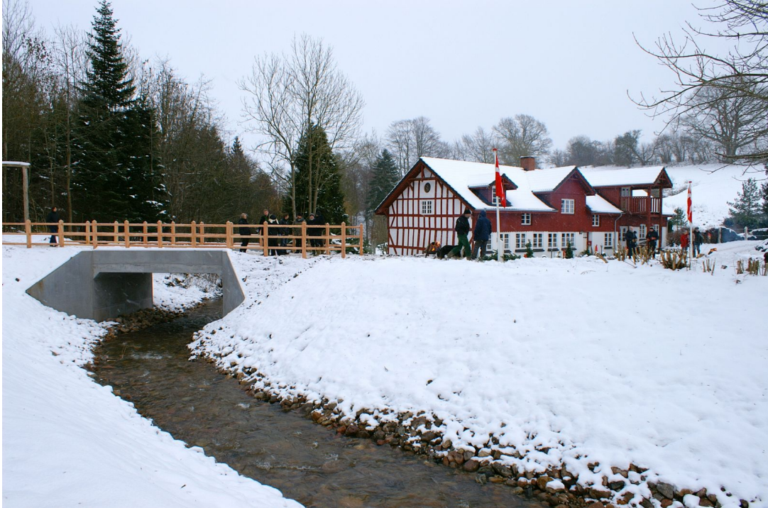
Her er det nye åløb og den nye bro, det var nødvendigt at bygge.
